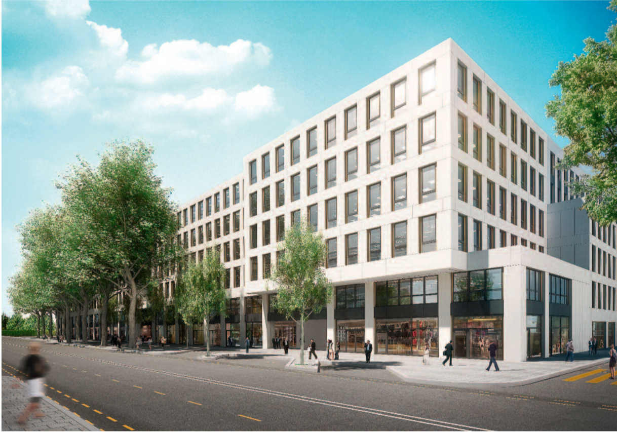
Vue depuis la Rue de Lyon.
